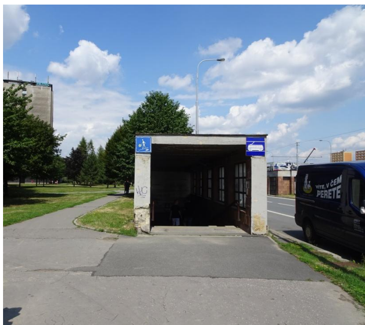
Fotografie č.6: Detail charakteristické vstupní čelní stěny schodišťových koridorů - výstup z podchodu u bytové zástavby. Poškozené omítky stěn.
