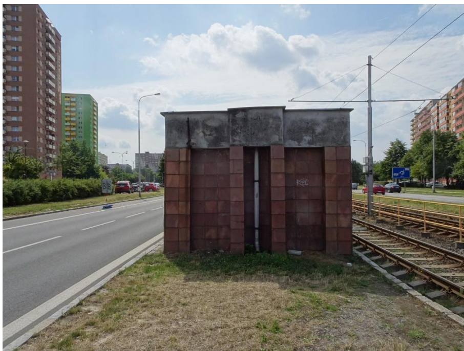
Fotografie č.5: Detail charakteristické čelní stěny schodišťových koridorů - výstup z podchodu u tramvajové zastávky ve směru Ostrava. Poškozené omítky atiky, poškozené stávající keramické obklady profilované čelní stěny, hnědé barvy, materiálově degradované střešní svody.
