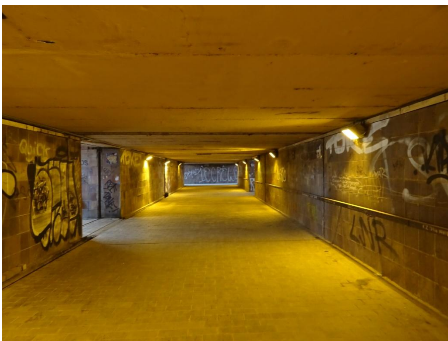
Fotografie č.10: Pohled do prostoru podchodu ze strany výstupu na náměstí. Znečištěné a poškozené povrchy konstrukcí podlah, stěn a stropu.
