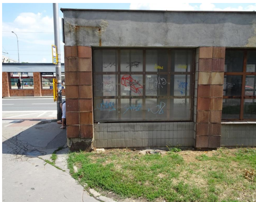
Fotografie č.4: Detail charakteristické boční stěny schodišťového koridoru - výstup z podchodu u hotelového domu Hlubina. Poškozené omítky atiky, poškozené stávající keramické obklady sloupů, hnědé barvy. Znečištěné prosklené výplně se zkorodovanými ocelovými rámy. Technicky opotřebovaný obklad parapetů z keramických pásků.
