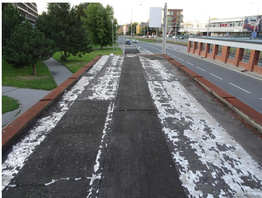
Fotografie č.11: Pohled na plochou střechu schodišťového koridoru Krytina střechy z poškozených asfaltovaných pásů.
